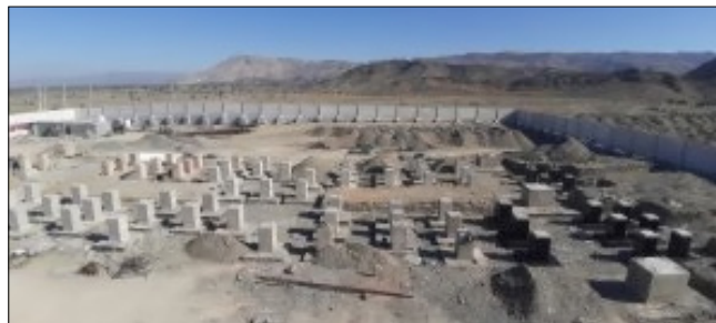
پست ۱۳۲/۲۰ کیلوولت در حال احداث نودژ
